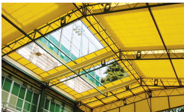
施工例：工場荷捌き場
