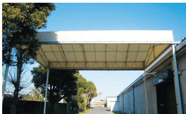
施工例：工場荷捌き場
